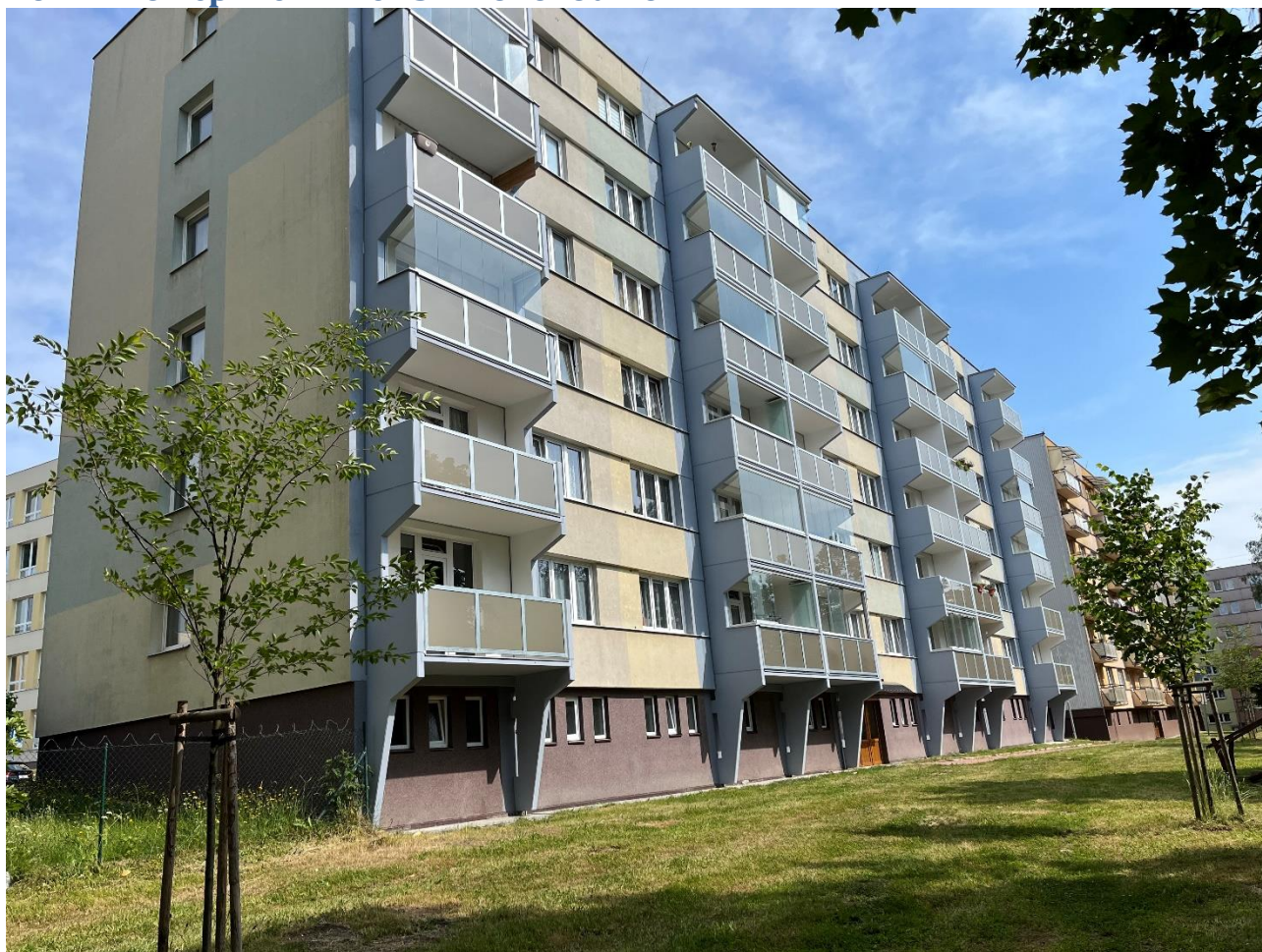
Pelhřimov čp. 1011-1013 – nové lodžie
