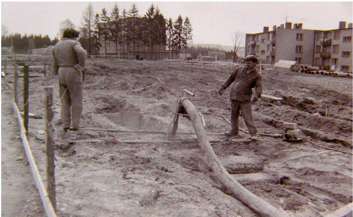
Foto z výstavby Sídliště Žirovnice
